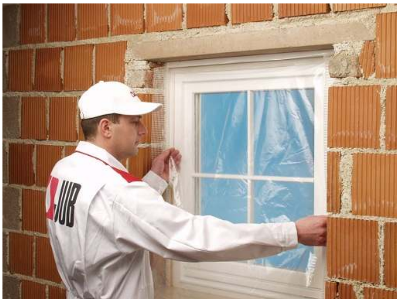
ΤΟΠΟΘΕΤΗΣΗ ΠΡΟΦΙΛ ΠΡΟΣΤΑΣΙΑΣ ΚΟΥΦΩΜΑΤΩΝ
