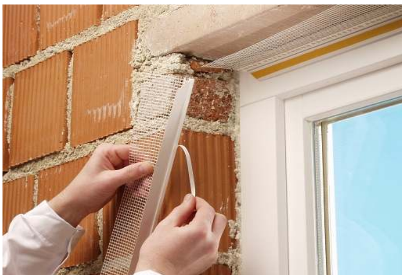
ΤΟΠΟΘΕΤΗΣΗ ΠΡΟΦΙΛ ΠΡΟΣΤΑΣΙΑΣ ΚΟΥΦΩΜΑΤΩΝ
