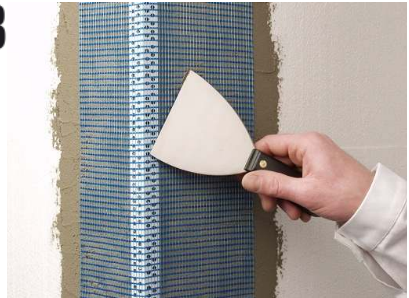
ΤΟΠΟΘΕΤΗΣΗ ΓΩΝΙΟΚΡΑΝΩΝ
