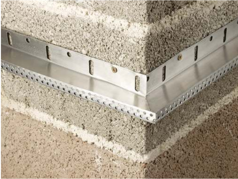
ΤΟΠΟΘΕΤΗΣΗ ΡΑΓΑΣ ΕΚΙΝΗΣΗΣ
