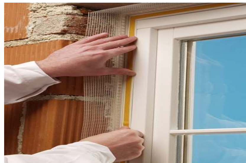
ΤΟΠΟΘΕΤΗΣΗ ΠΡΟΦΙΛ ΠΡΟΣΤΑΣΙΑΣ ΚΟΥΦΩΜΑΤΩΝ
