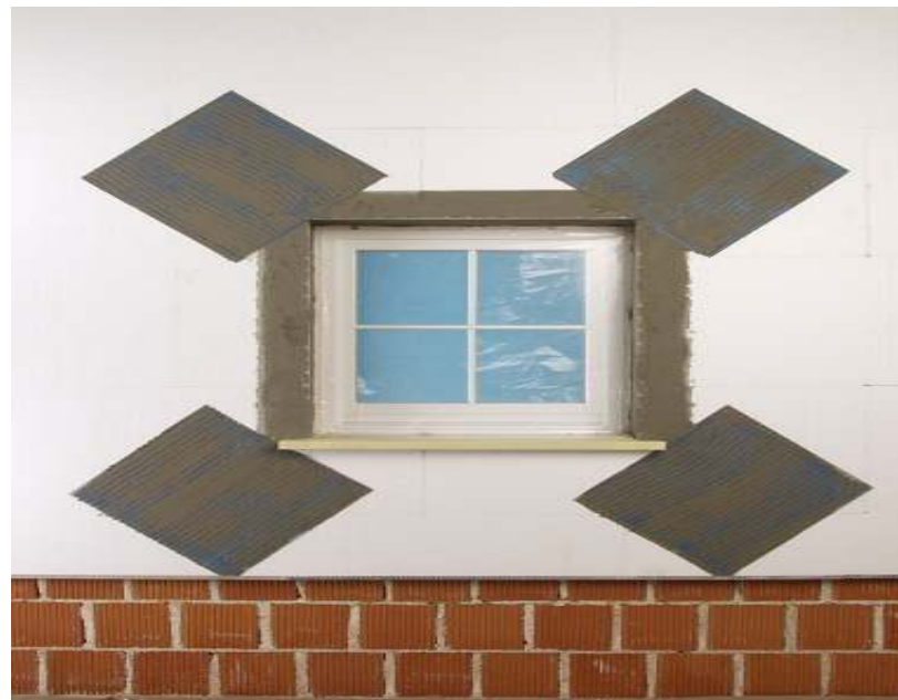
ΤΟΠΟΘΕΤΗΣΗ ΓΩΝΙΑΚΩΝ ΠΛΕΓΜΑΤΩΝ
