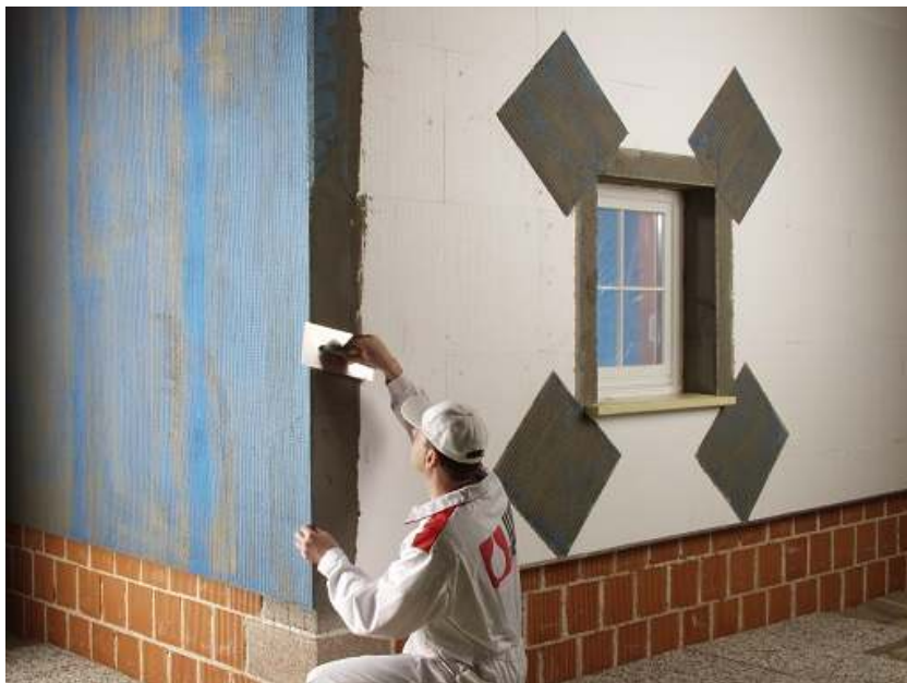
ΤΟΠΟΘΕΤΗΣΗ ΓΩΝΙΑΚΩΝ ΠΛΕΓΜΑΤΩΝ
