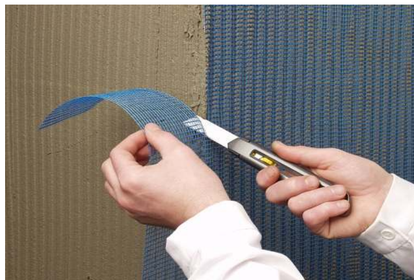
ΤΟΠΟΘΕΤΗΣΗ ΠΛΕΓΜΑΤΩΝ
