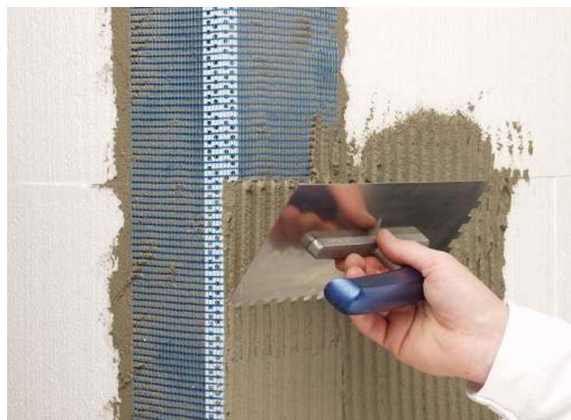
ΕΦΑΡΜΟΦΗ ΚΟΛΛΑΣ ΥΑΛΟΠΛΕΓΜΑΤΩΝ
