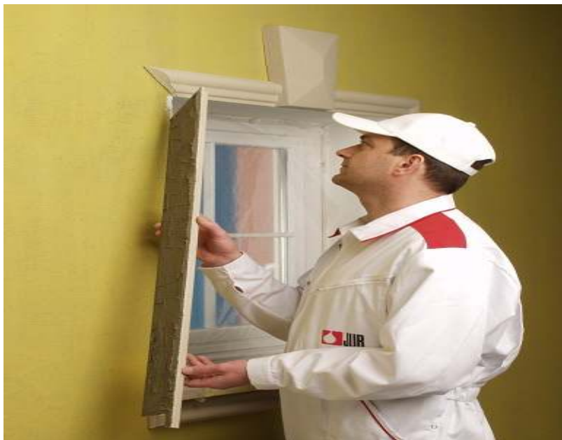
ΤΟΠΟΘΕΤΗΣΗ ΚΟΡΝΙΖΩΝ
