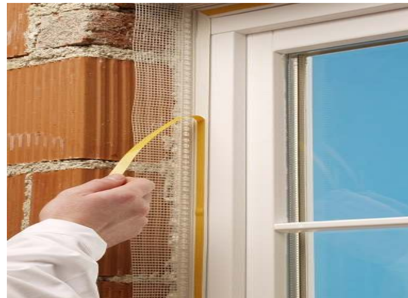
ΤΟΠΟΘΕΤΗΣΗ ΠΡΟΦΙΛ ΠΡΟΣΤΑΣΙΑΣ ΚΟΥΦΩΜΑΤΩΝ
