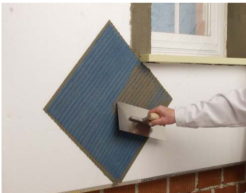
ΤΟΠΟΘΕΤΗΣΗ ΓΩΝΙΑΚΩΝ ΠΛΕΓΜΑΤΩΝ
